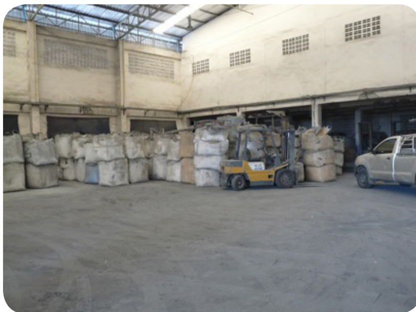
รูปที่ 16 สภาพภายในโรงงาน
